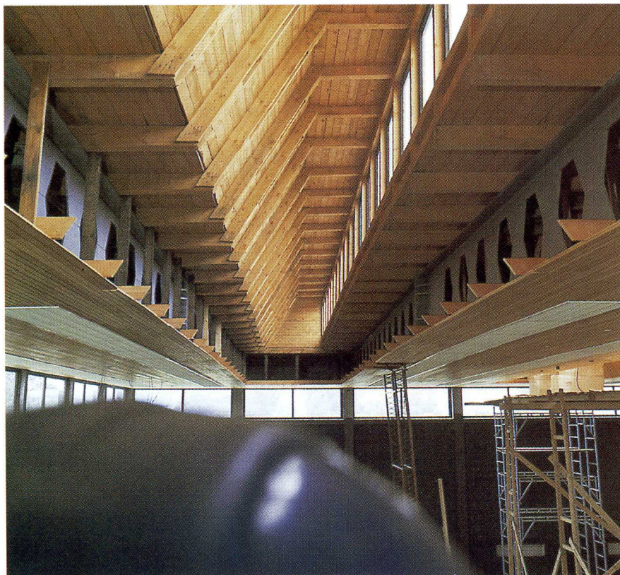
Wabenträger im Stahl-Skelettbau
