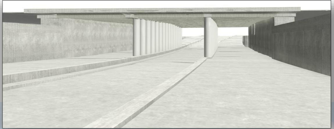
Mehrfeldrahmen mit Spannbetonüberbau und lichter Weite von ca. 24 m
