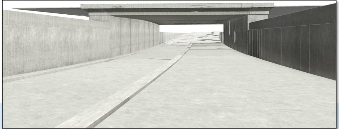
Einfeldrahmen mit Spannbetonüberbau und lichter Weite von ca. 16 m
