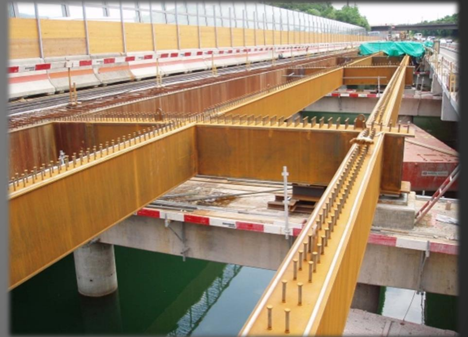
N01 Lehnenviadukt in Killwangen
