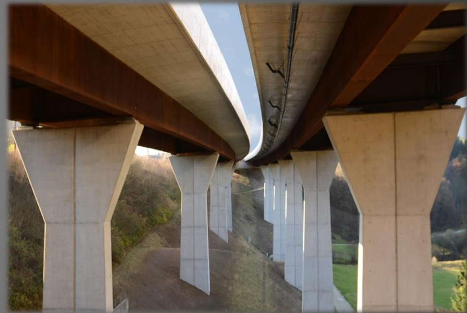
N01 Bünzthalviadukt in Othmarsingen (AG)
