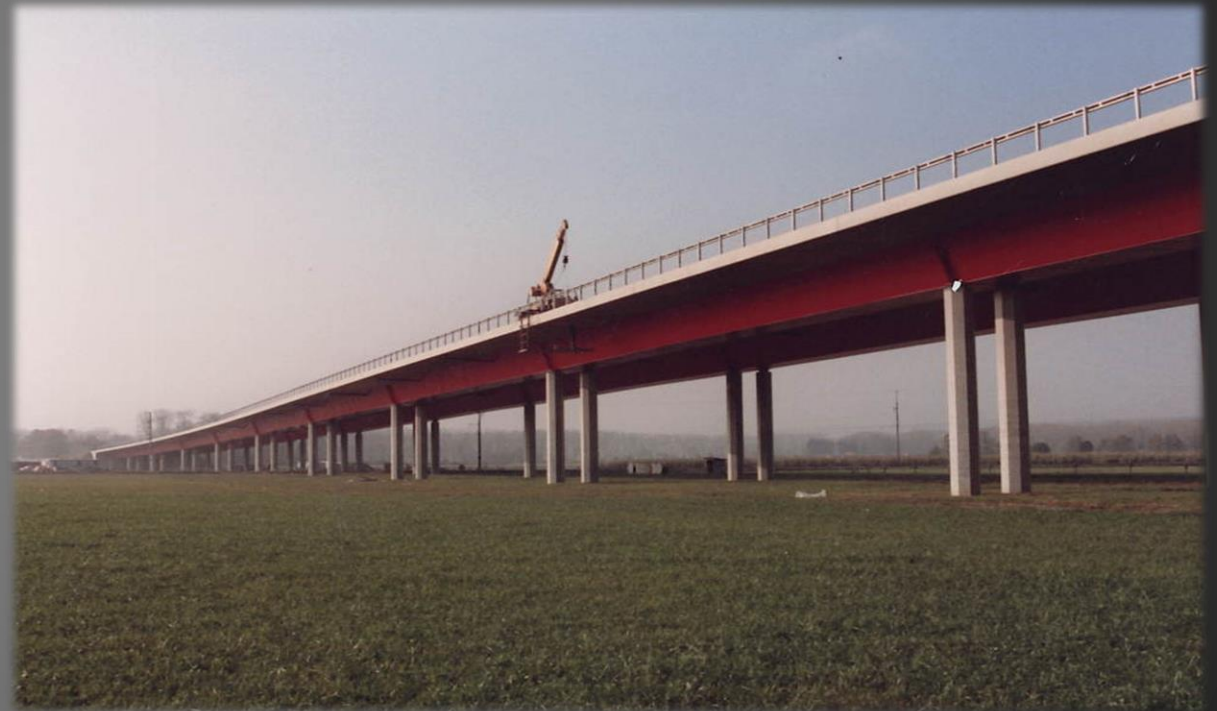
N01 Viadukt - Bois de Rosset
