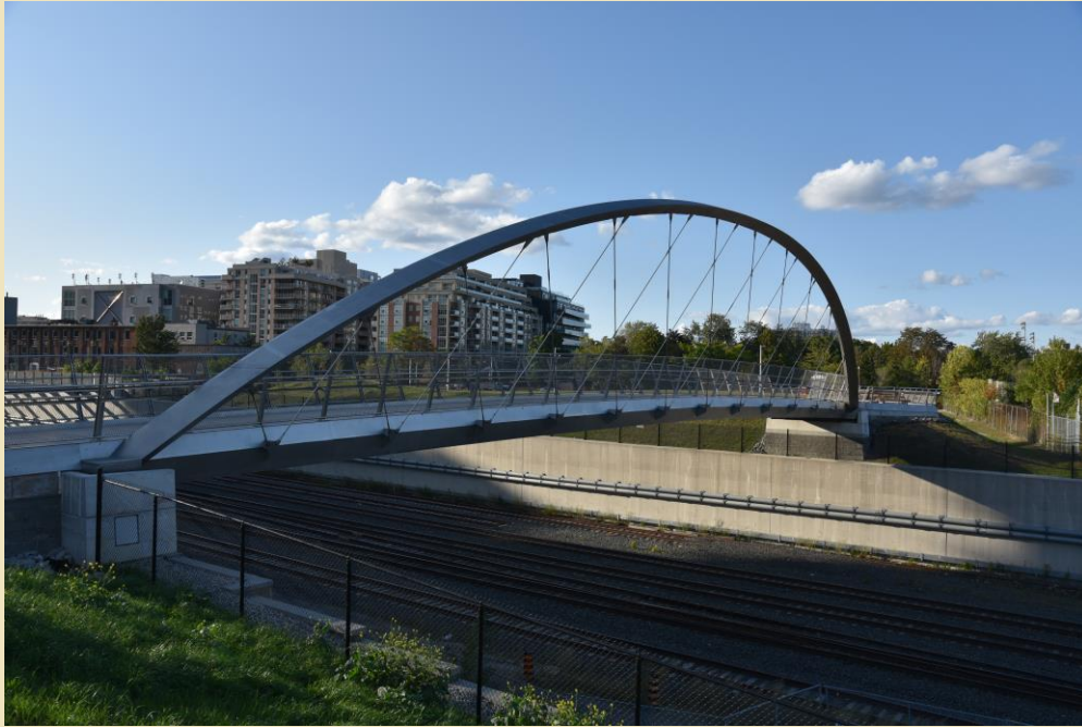
Fort York Bridge, Toronto, Kanada
