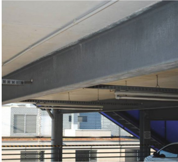
Abbildung 33 - Korrosionsfrei: Feuerverzinktes Parkhaus
