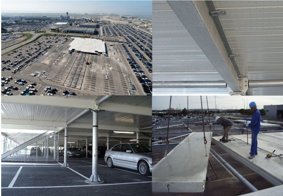
Abbildung 35 - Temporäre Parkgaragen P6 und P12 des Flughafens Marseille mit lösbaren Detailverbindungen für Tragwerk und Parkdecks. Bilder: Vincent Birarda, ARVAL, ArcelorMittal Construction France
