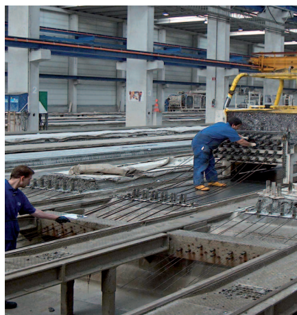
Bild 8: Einfädeln des Spann Stahls
