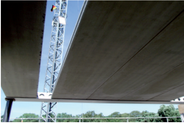
Bild 16: Sichtkontrolle von unten
