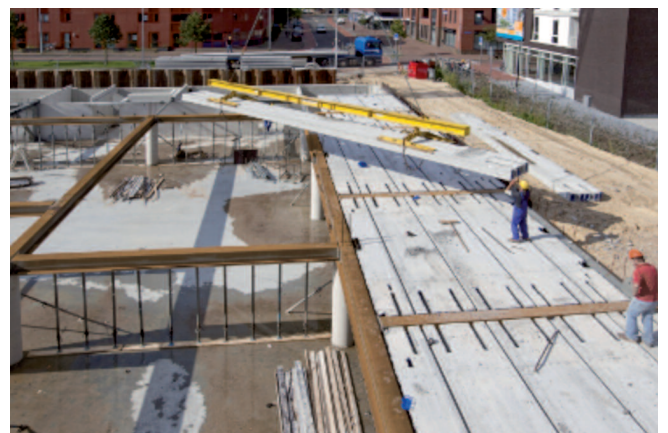
Bild 15: Deckenmontage in deckengleichen Stahlträgern
