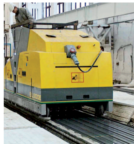
Bild 9: Extruderfertiger im Einsatz
