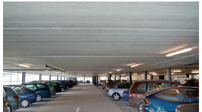
Bild 2: Parkhaus in Nijmegen, NL
