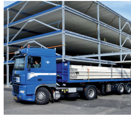
Bild 6: Parkhaus in Köln
