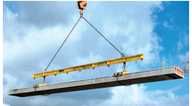
Bild 1: Montage von Spannbeton-Fertigdecken
