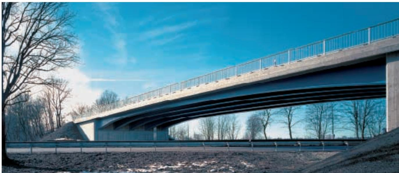
Abb. 1: BAB A 8 West; Überführungsbauwerk in Verbundfertigteil-Bauweise
