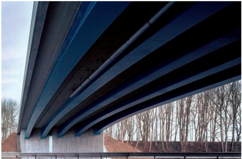
Abb. 2: Untersicht eines Rahmenbauwerkes in Verbundfertigteil-Bauweise
