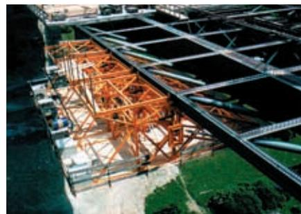
Abb. 11: Konstruktion des Schalwagens
