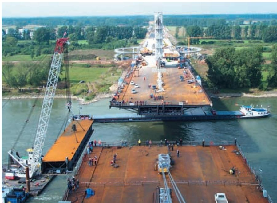
Abb. 9: Einheben des Schlusstückes
