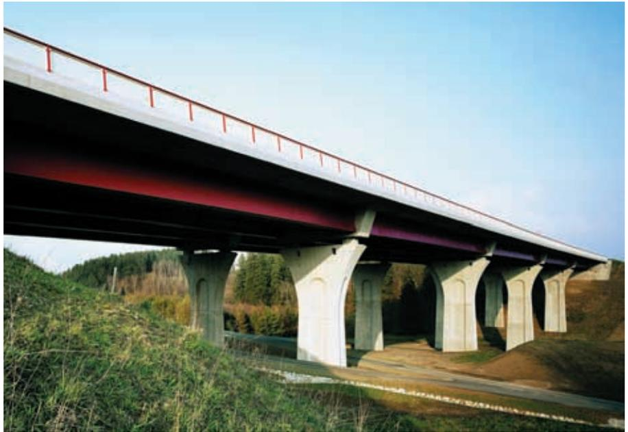
Abb. 4: BAB A 93 Talbrücke Oberhartmannsreuth; Überbau in Verbundfertigteile-Bauweise
