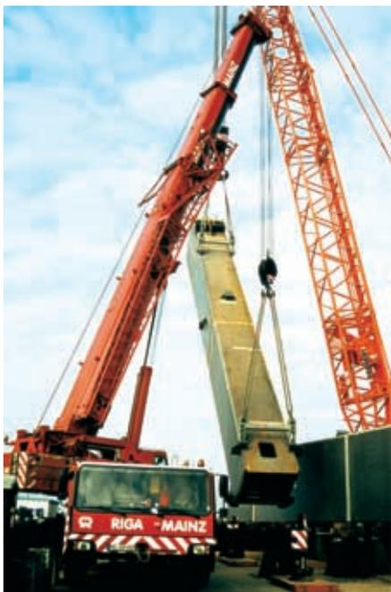
Abb. 8: Montage des Pylons
