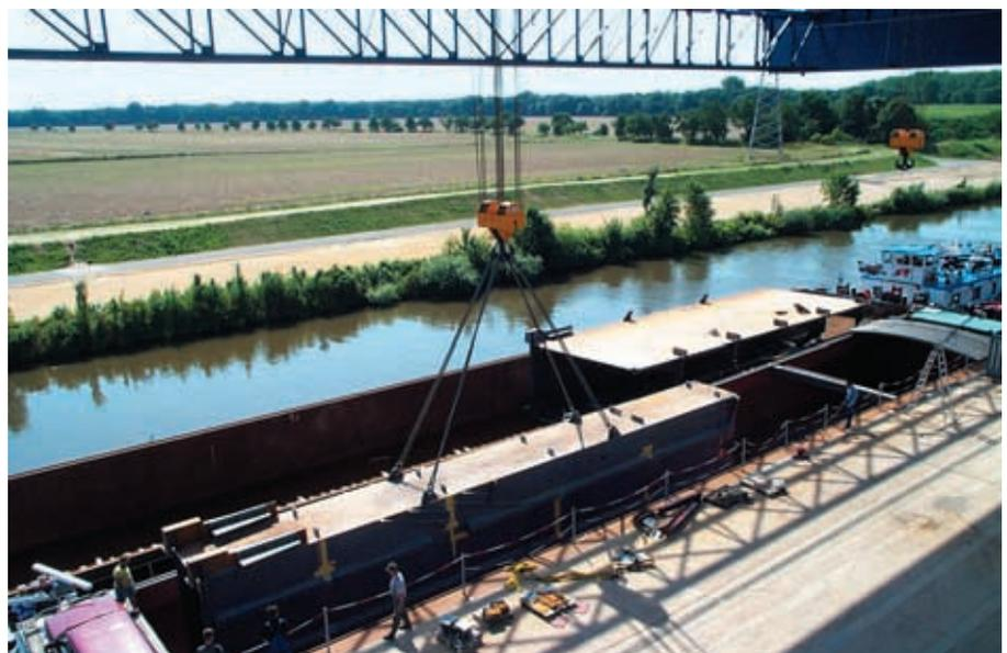
Abb. 7: Verladen einer Brückensektion mit Dreierteilung
