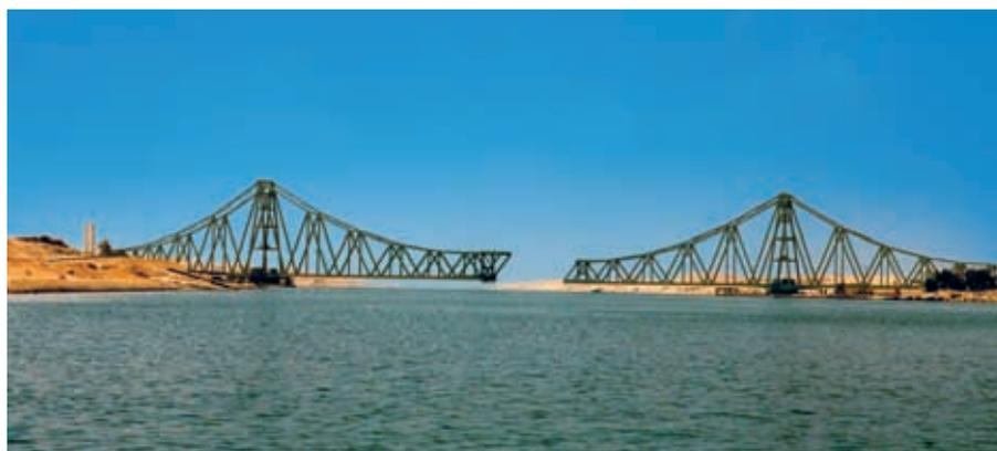
400 mm Nenndurchmesser, die auf 2 kegeligen Bahnen aus 34 CrNiMo 6V von 17,1 m Durchmesser laufen und im Rollenträger geführt sind. Zum Drehen der beiden Brückenausleger sind am Drehkranz 2 um 180° versetzte Antriebe angeordnet. Die Drehung erfolgt beim Öffnen im Uhrzeigersinn und beim Schließen gegen den Uhrzeigersinn. Ein Öffnungs- bzw. Schließvorgang dauert 29 Minuten, wovon etwa die Hälfte auf den reinen Drehvorgang entfällt.
