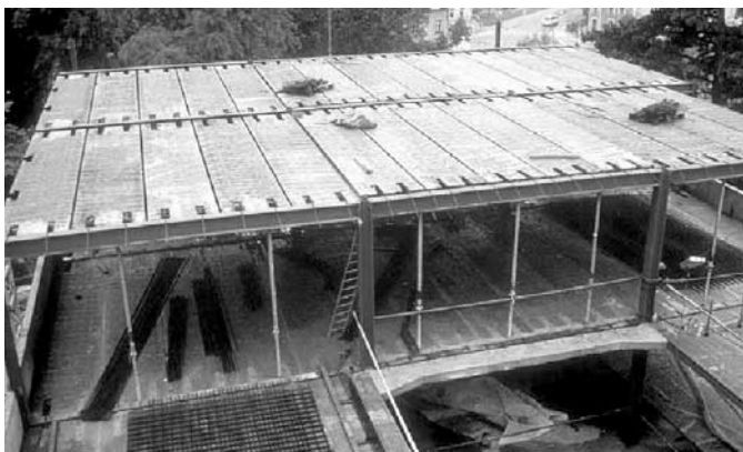
Bild 4a/b: Stahlskelettkonstruktion mit Ergänzung durch Spannbeton-Fertigdecken
