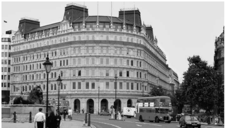
Bild 1b (unten): Grand Buildings Trafalgar Square/ London (Endzustand): Die Stahlkonstruktion ist nicht mehr sichtbar.
