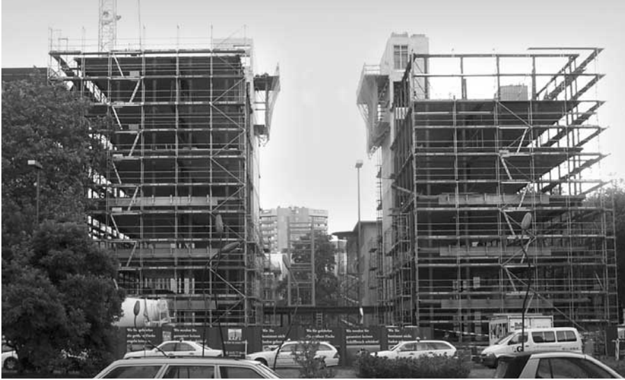
Bild 3: Stahlbau macht es möglich: Ein Geschoss wurde in 8 Tagen errichtet (© Petzinka Pink Architekten)
