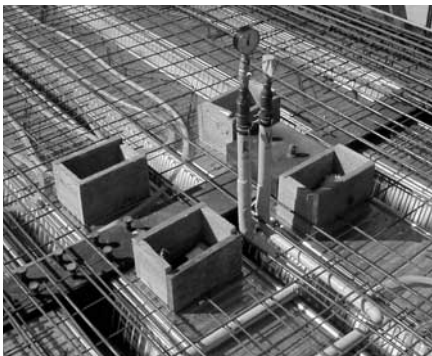
Bild 5 a - d: Thermisch aktive Stahl-Flachdecke „Slimdek“ in einem Berliner Büro- und Sportzentrum mit velta-contec-Modulen
