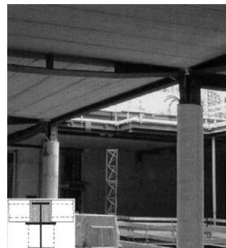
Bild 24b (rechts): Flachdecke in Trockenbauweise mit Draheim-Trägern
