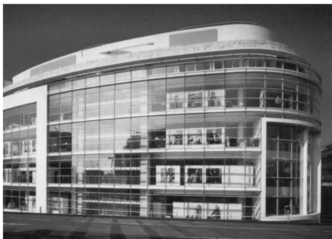
Bild 24a (links): Textilkaufhaus in Düsseldorf mit Flachdecke in Trockenbauweise mit Draheim-Trägern (© HOCHTIEF/ Andreas Wiese)
