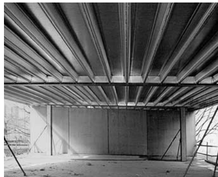
Bild 5 a - d: Thermisch aktive Stahl-Flachdecke „Slimdek“ in einem Berliner Büro- und Sportzentrum mit velta-contec-Modulen
