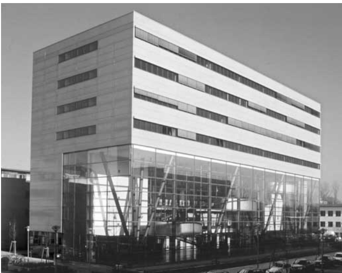
Bild 15 (links): Innovationszentrum für Informatik in Berlin in „Slimdek“-Bauweise (© BauBild/Stephan Falk)
