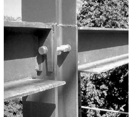
Bild 2a/b: Detailausbildung Stütze – Riegel bei Slimflor-Konstruktionen
