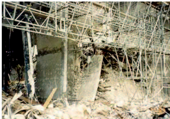
Bild 5: Verlust von Erdgeschoss-Stützen durch einen Bombenanschlag – Kansallis House, London 1993 (Moore, 2002)
