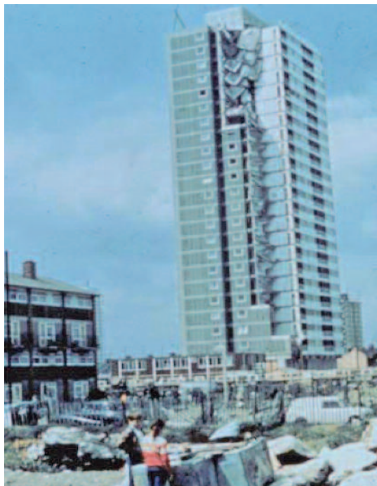
Bild 6: Teileinsturz eines Wohngebäudes nach einer Gasexplosion – Ronan point, London 1968 (Moore, 2002)
