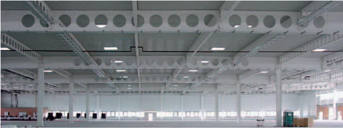
Zur weiteren Optimierung der Konstruktion wurden die Cellform-Träger als Hybridträger konzipiert, die obere Trägerhälfte in Baustahl S355, die untere mit dem Feinkornbaustahl S460. Die Hauptträger bestehen aus Profilen W 1100 x 400 x 499 (oben) und W 1100 x 400 x 433 (unten), die Nebenträger aus IPE 750 x 147 (oben) und IPE 600 (unten). Die industrielle Vorfertigung der Träger im Werk des Stahllieferanten ermöglichte eine pro-
