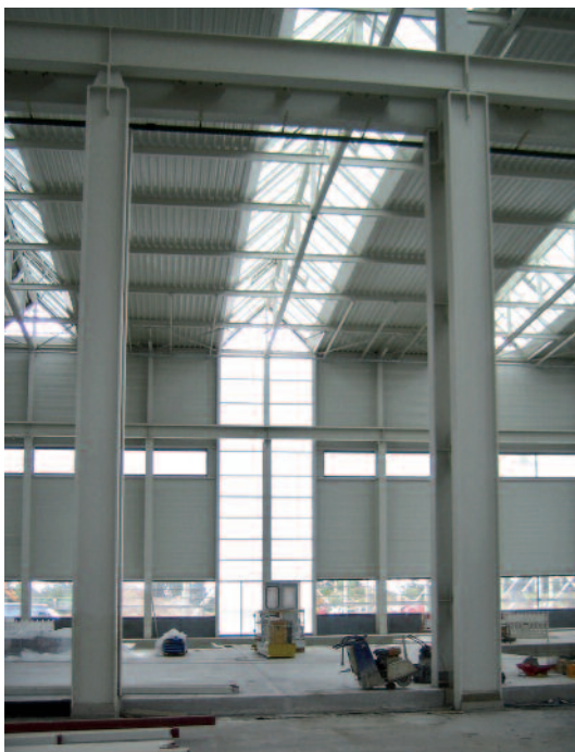
Mittelstützen mit Kranbahn
