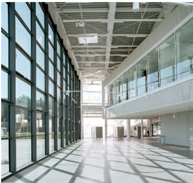
Innenansicht – Fassade und Dachtragwerk
