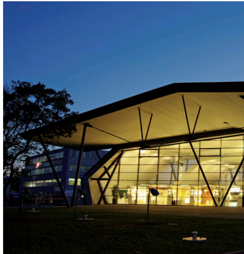
Die komplexe Tragstruktur bei Nacht
