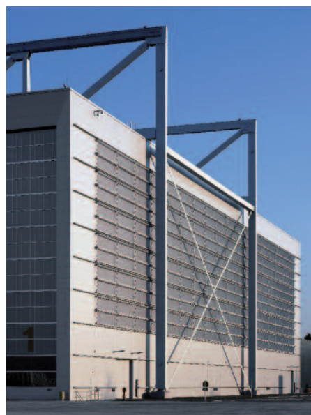
Westfassade mit außen liegenden Stützen
