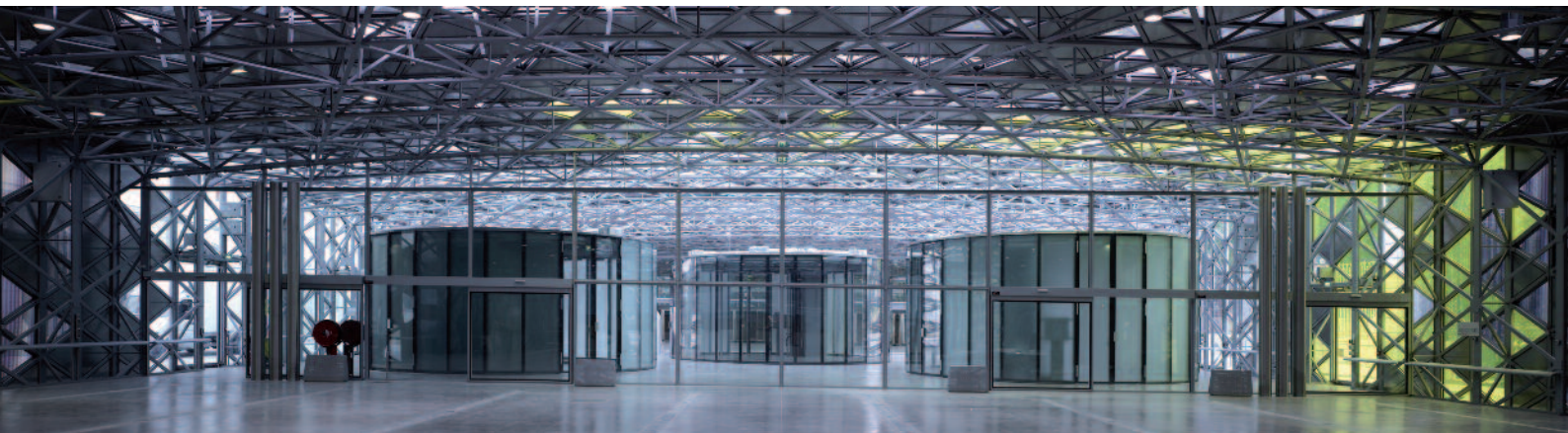
Stützenfreier Innenraum mit sichtbarem Raumtragwerk
