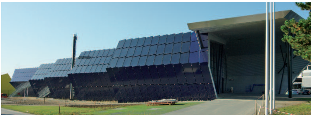
Photovoltaik Elemente in der Außenhaut
