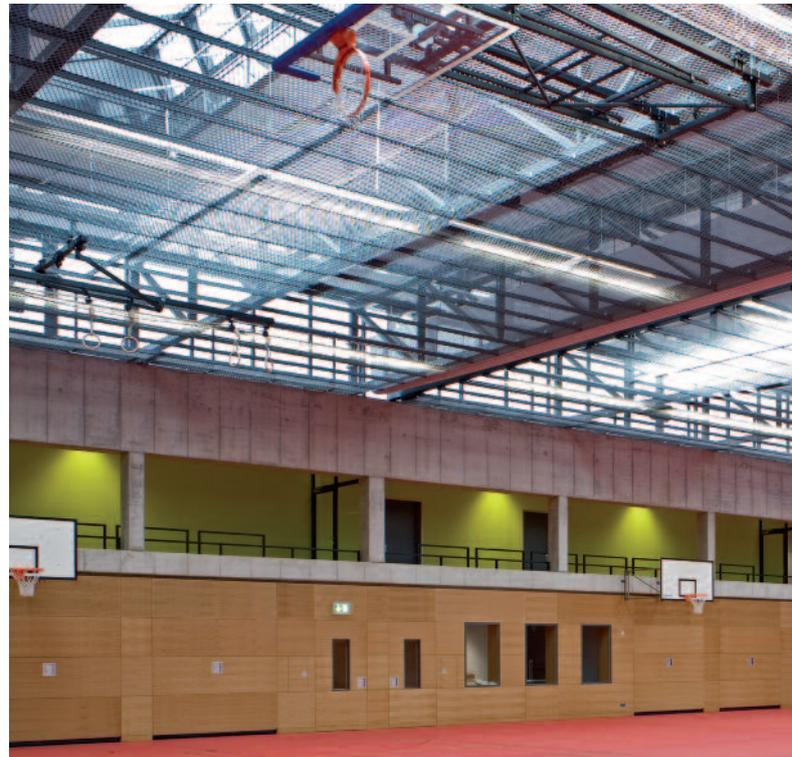
Die beiden Hauptnutzungen Pausenbereich und Sportbereich sind gleichermaßen separiert als auch verbunden durch eine „begehbbare Mauer“ aus monolithischem Leichtbeton. Sie beinhaltet die Umkleiden, Nebenräume der Pausenhalle, Fahrräder und Geräte.
