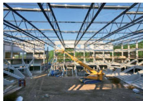
Bild 3: Montage der Dach-Stahlkonstruktion einer Mehrzweckhalle
