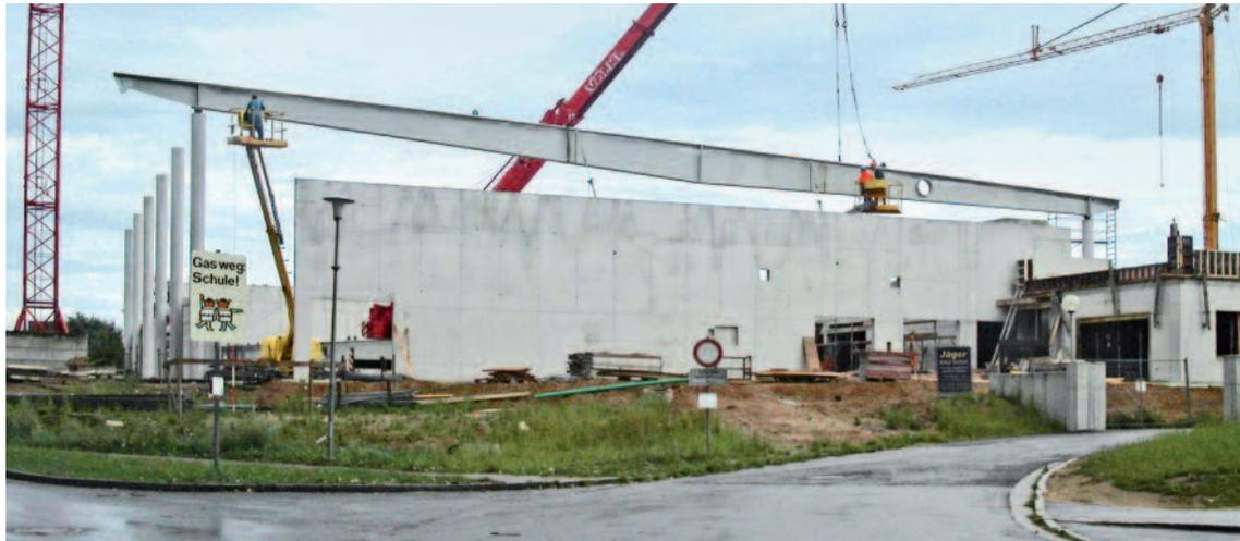
Die Aussteifung der Dachebene erfolgt zum einen über die quer zu den Hauptbindern angeordneten Stahlpfetten aus den Profilen HEA 220 und HEB 220, den zwei durchgehenden Dachverbandsfeldern aus Rundstahl mit 24 mm Durchmesser, und zudem über die Dacheindeckung mittels Trapezblech. Die Pfetten und weitere Querträger dienen zusätzlich der Anbringung von Sportgeräten und der Beleuchtung.
