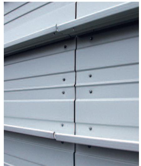
Bild 42: Abdichten im Längsstoß und an Endauflagern
