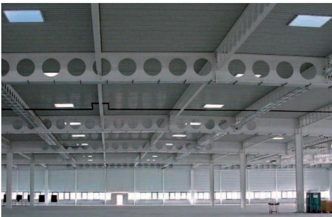
Bild 26: Lochstegträger als Tragkonstruktion einer Halle
