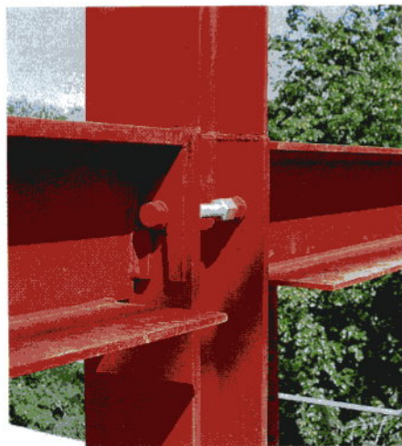
Bild 1 Anschluß an Stahlstütze
