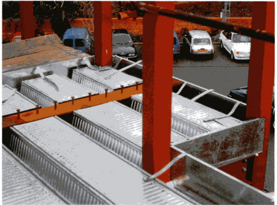
Bild 3 Decken-Aufsicht mit Profilsicken-Formteilen und Rand-Formteilen
