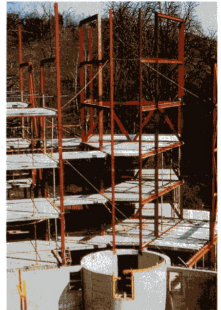
Bild 3 Verwaltungsgebäude Esch / Alzette (Luxemburg): Montage Stahlskelett mit IFB-Flachdecke
