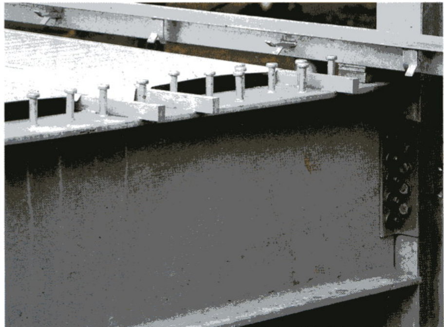
Bild 1 Detail Knaggenauflagerung
