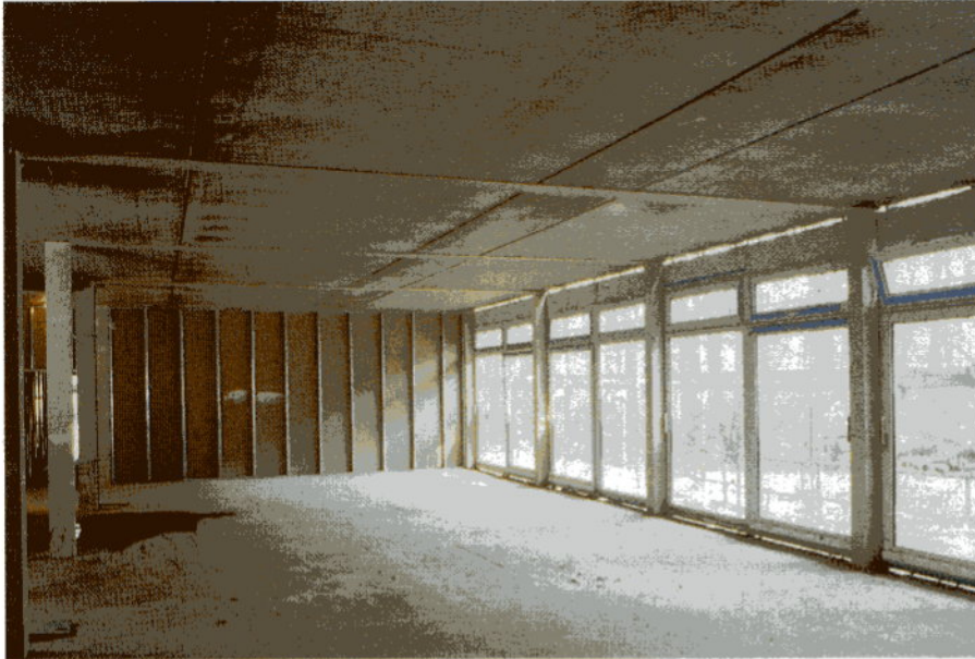
Bild 4 Glatte Decken-Untersicht durch Integration der Stahlträger
