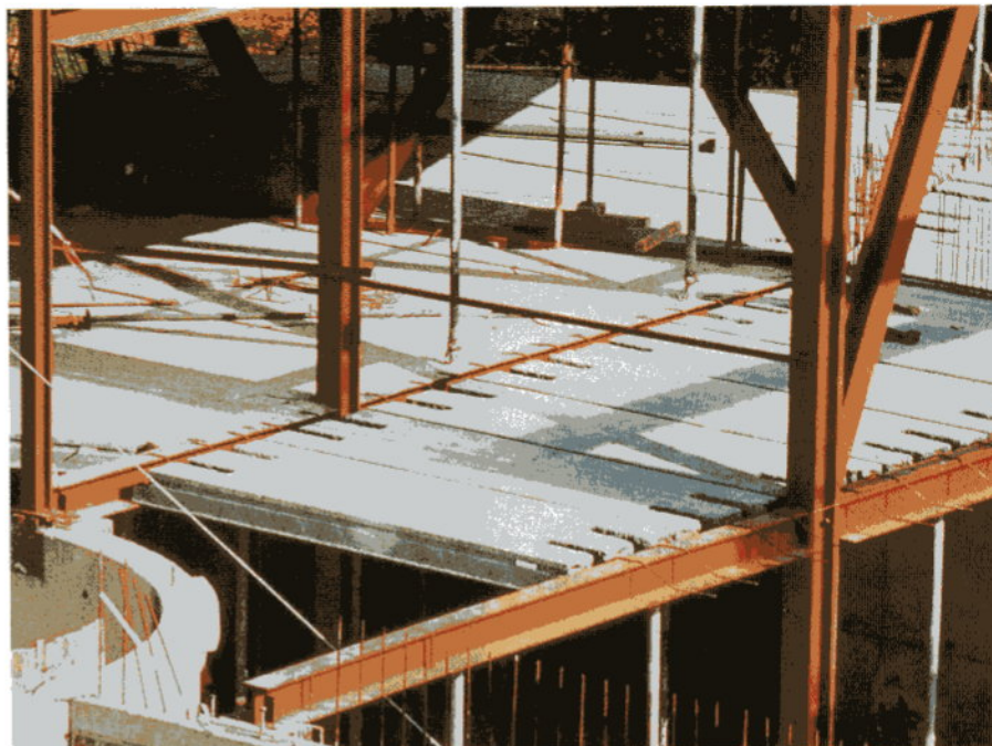
Bild 2 Geschoßdecke: Betonplatten auf Träger-Unterflansch (Trockenbauweise)
