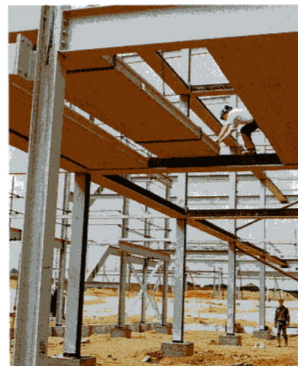
Bild 6 Geschoßdecke: Einheben der Deckenelemente
