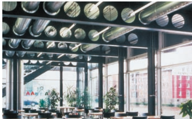
Bild 29: Installationsführung bei Lochstegträgern
