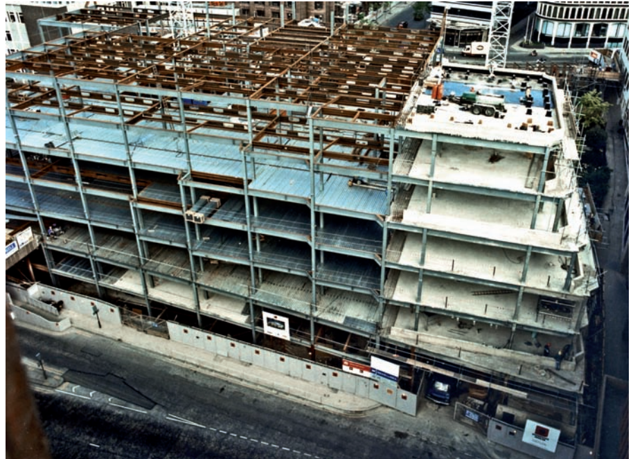
Bild 1: Typischer Stahlskelettbau
