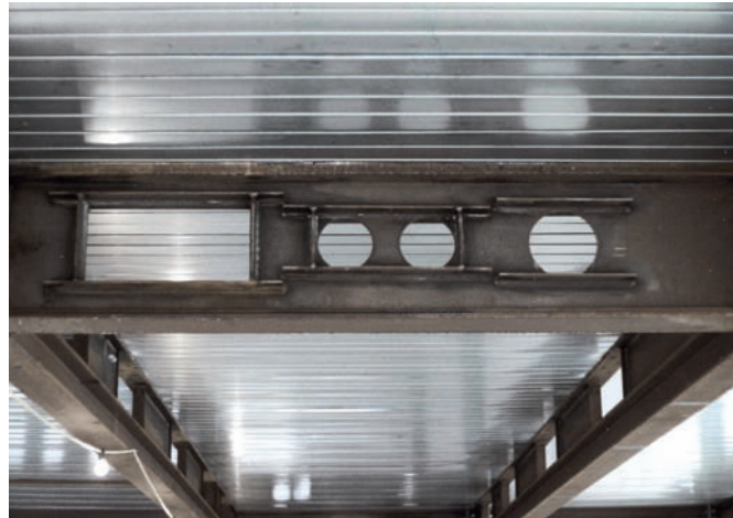
Bild 28: Stegdurchbrüche für die Installation
