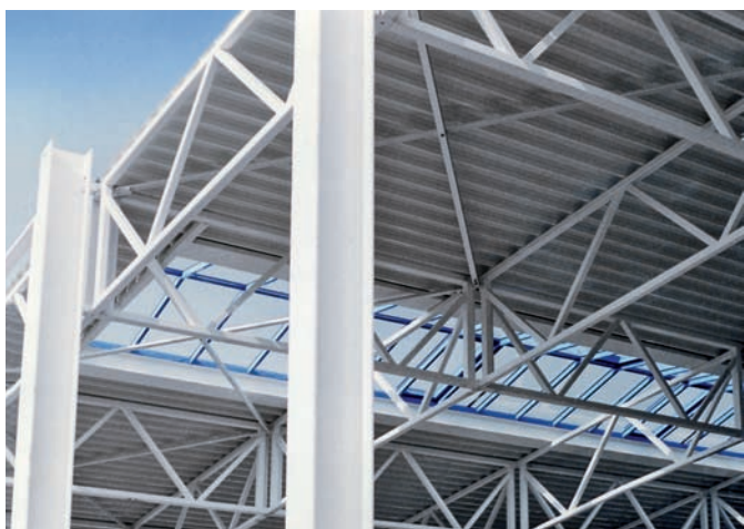
Bild 20: Fachwerkträger
