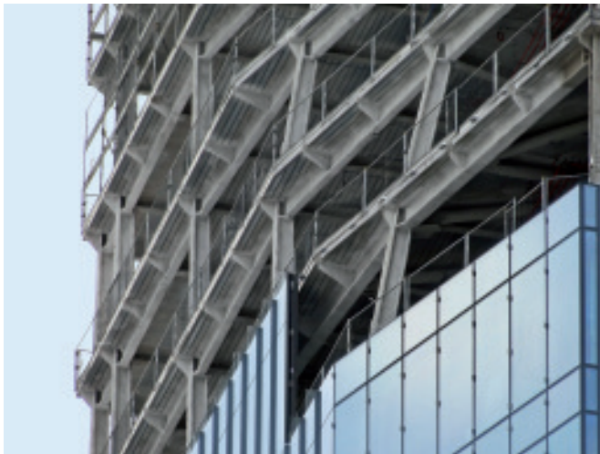
Bild 2. Stahltragwerk mit schrägen Stützen
