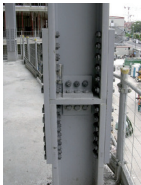
Bild 4. Typischer Stützenstoß
