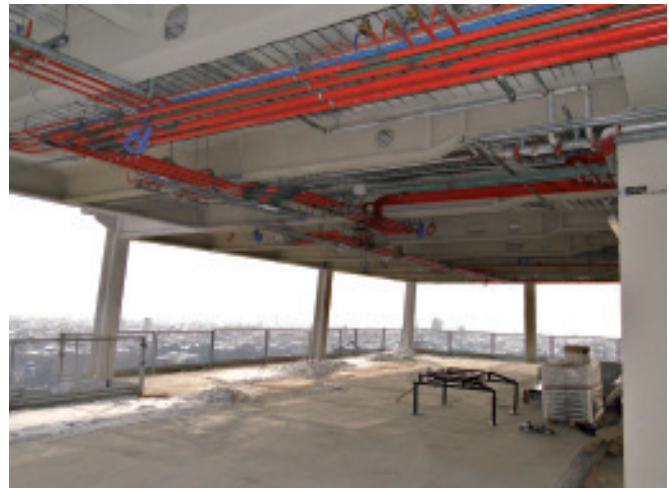
Bild 12. Weitgespannte Verbundträger für maximale Flexibilität
