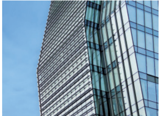
Bild 10. Geschosshohe Fassade mit außenliegendem Sonnenschutz © bauforumstahl
