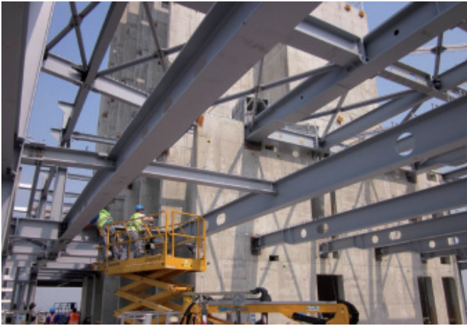
Bild 7. Anschluß der Träger an den Kern in der 21. und 22. Etage © Stahlbau Pichler
