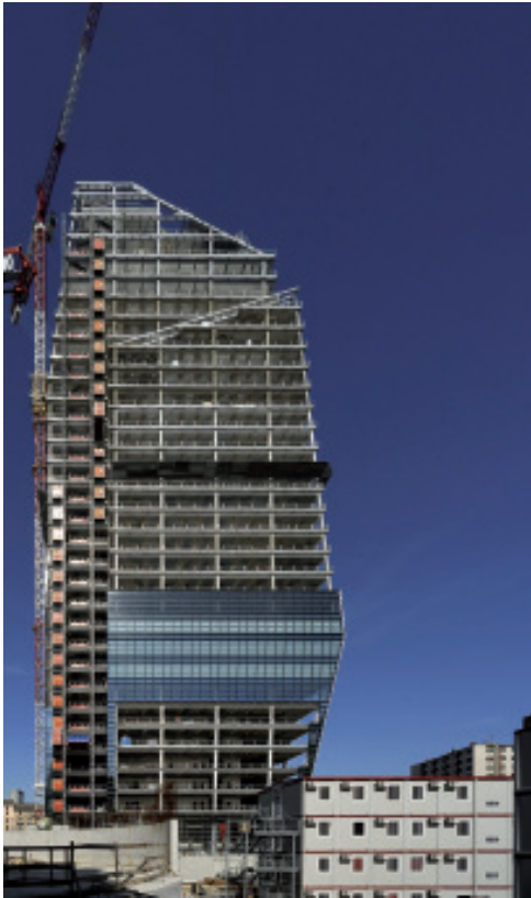
Bild 9. Das Stahltragwerk steht © Stahlbau Pichler | Oscar DaRiz
