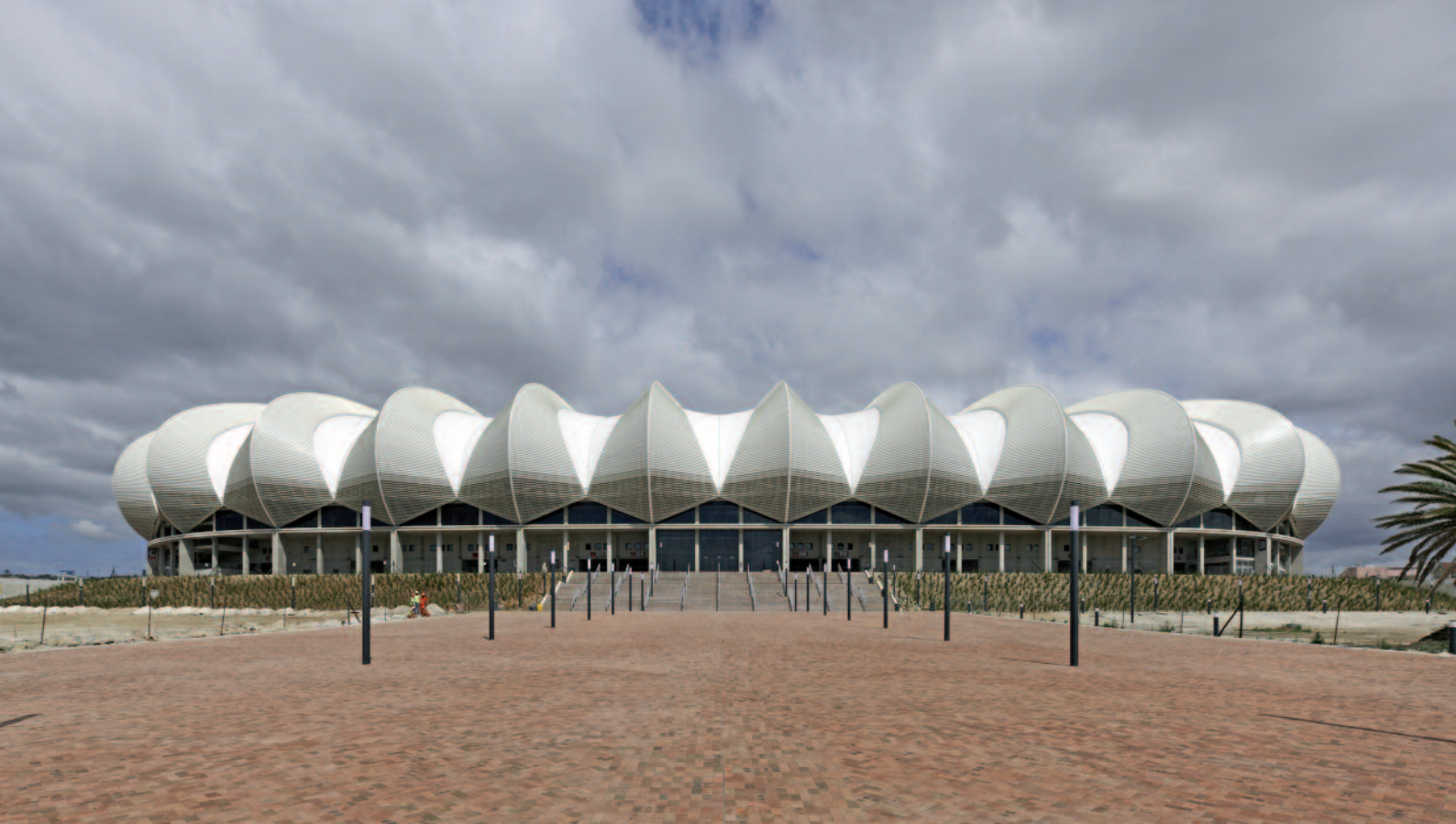
» Oben: Tribürendach aus blechgedeckten Kragarmen » Unten: Grundrisse Ebene 2 und 6, Dachaufsicht, M 1:5000
