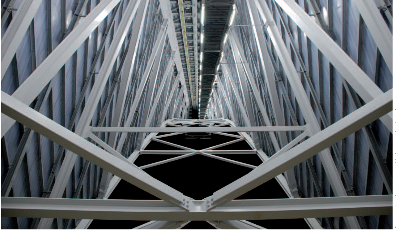
» Treppe und Schrägaufzug innerhalb der Tragstruktur
