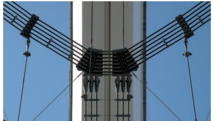
» Oben: Ansicht mit Haupteingang » Unten: Untersicht des Umlenk-Zugringknotens
