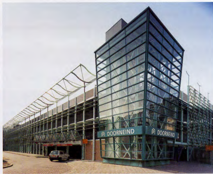
18b. Außenliegende Tragkonstruktion: Parkhaus Doorneid (NL).
