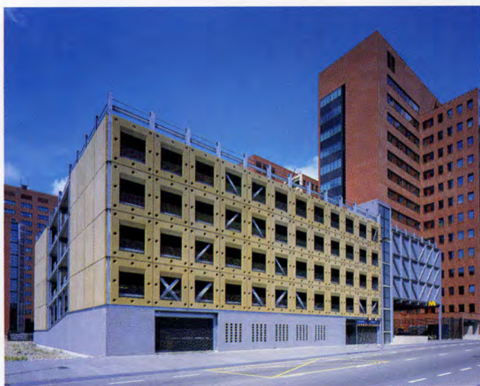
18a. Innenliegende Tragkonstruktion: Parkhaus Wilhelminahof, Rotterdam (NL)
