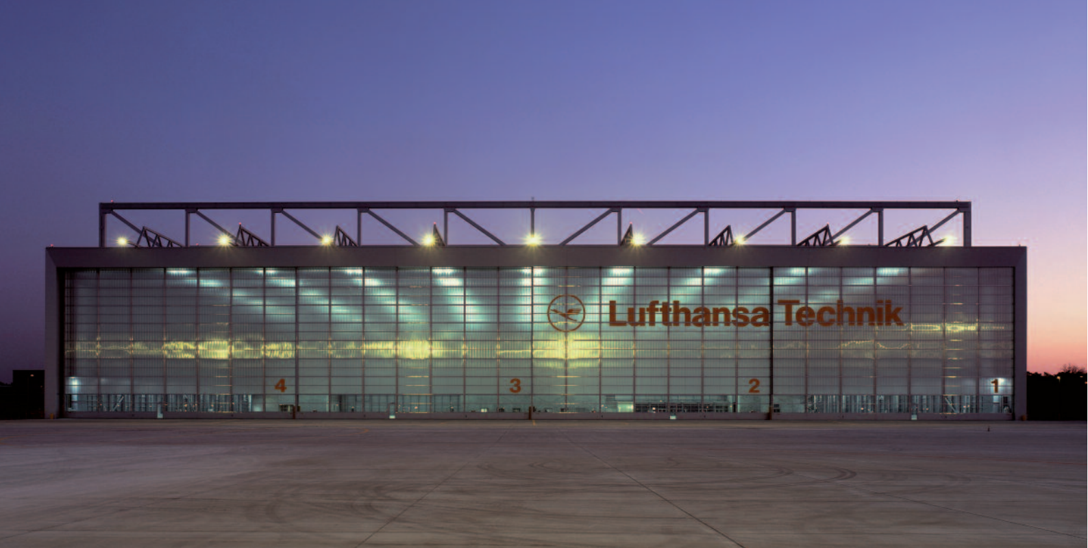
» Nordfassade mit Hangartoren
