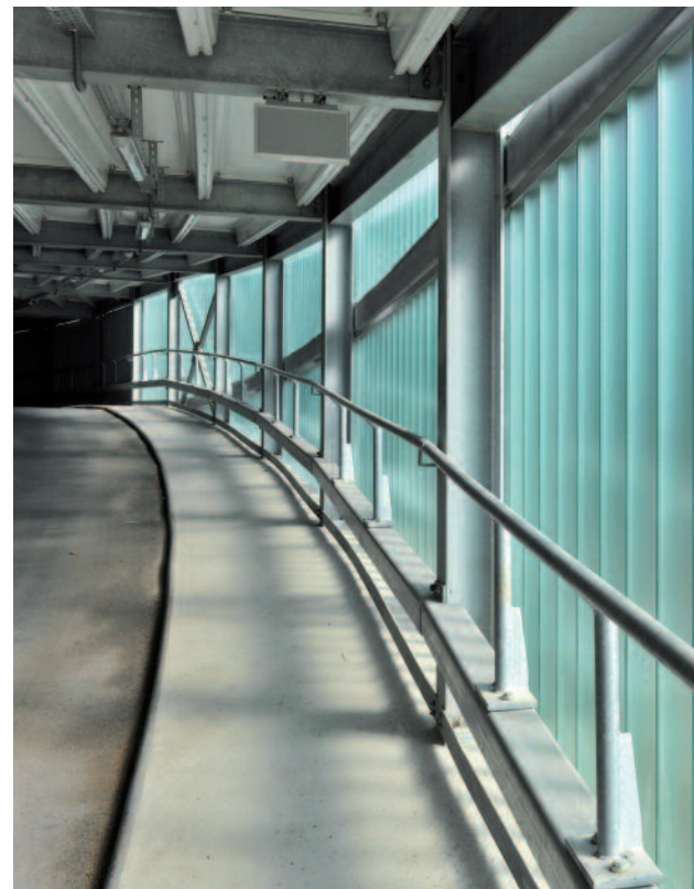
» Oben: Filigrane Hülle mit tragender Struktur aus Stahl » Unten: Verglaste Zufahrtsrampe
