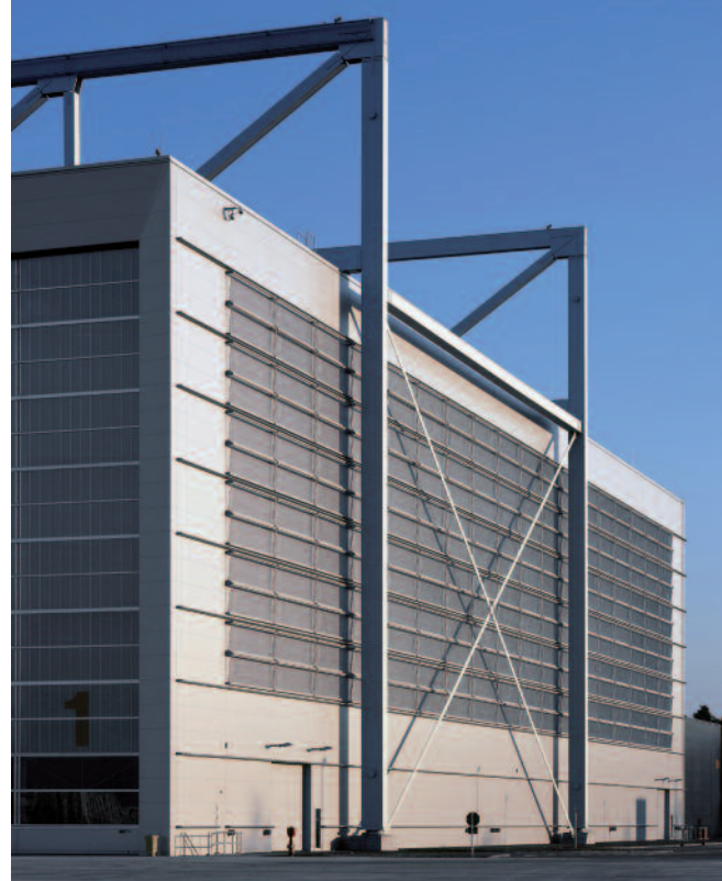
» Westfassade mit außen liegenden Stützen
