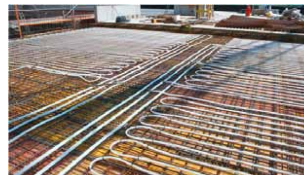
Abb. 4.4.17: Rohrschlangen BKT; Quelle Fa. uponsor
