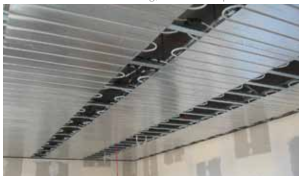
Abb. 4.4.15/16: Deckenheizung; Quelle: Fa. uponsor
