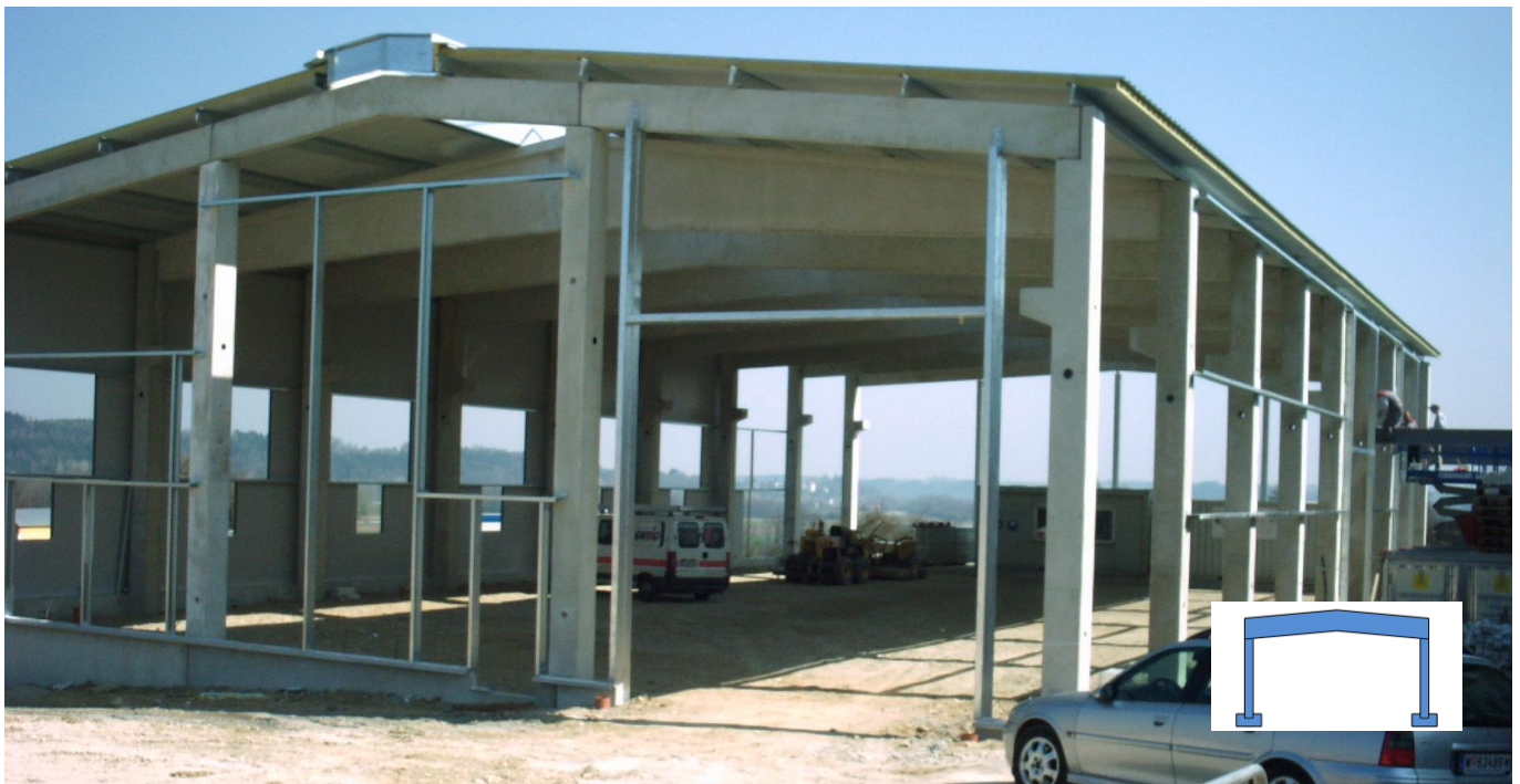
Abbildung 6: Halle in Stahlbetonbauweise und Symbol für Stahlbeton-Tragwerk
