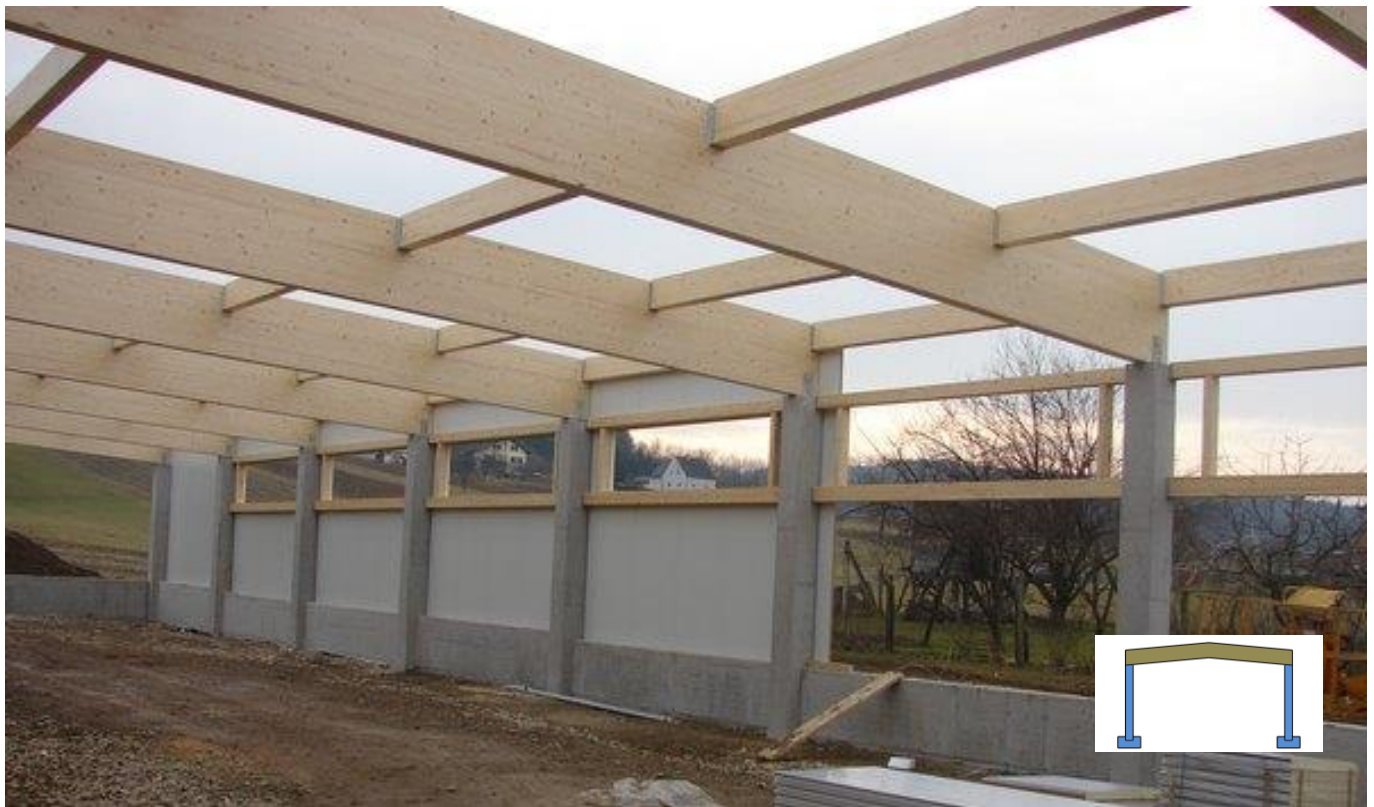
Abbildung 7: Halle in Stahlbeton/Holz-Bauweise und Symbol für Stahlbeton-BSH-Tragwerk
