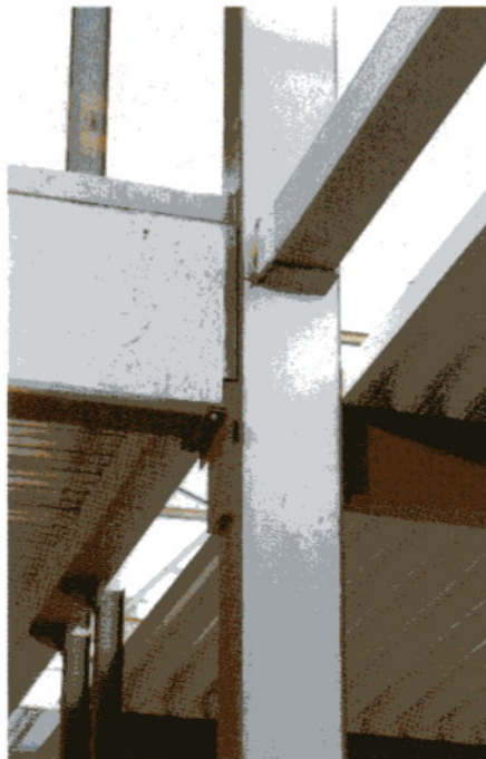
Knaggenanschluß an kammerbetonierter Verbundstütze
