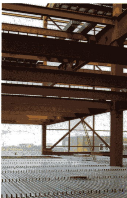
Trapezblech-Verbunddecken im Industriebau
