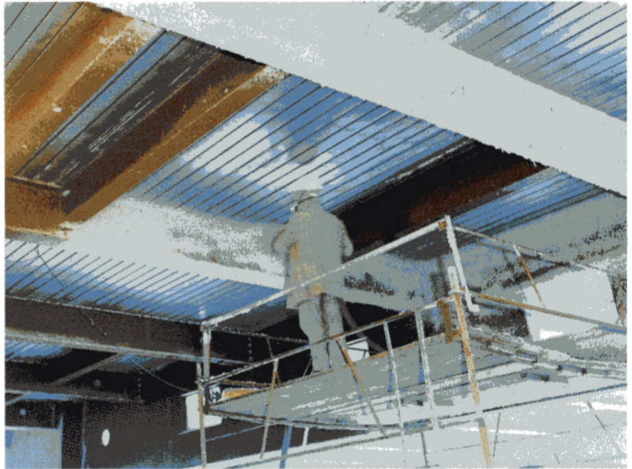
Asbestfreier Spritzputz für Stahlträger
