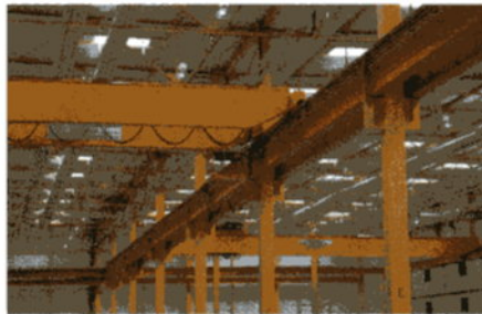
Kammerbetonierte Verbundstützen mit Kranbahnauflagerung
