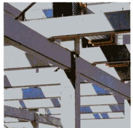
Feuerbeständige Verbundkonstruktion mit kammerbetonierten Trägern und Stützen
