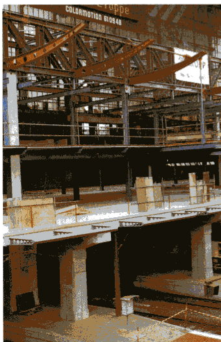
Gleisüberbauung im Hamburger Hauptbahnhof
