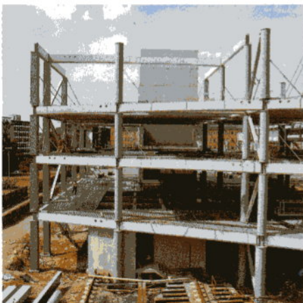
Betongefüllte Hohlprofile als feuerbeständige Verbundstützen
