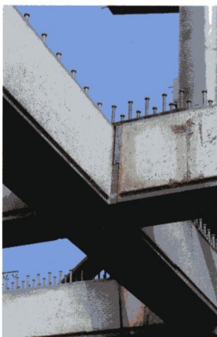
Knaggenanschluß von kammerbetonierten Verbundträgern
