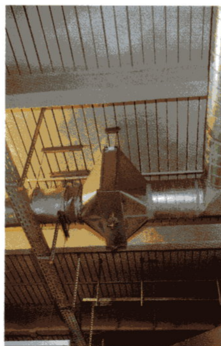
Trapezblech-Verbunddecken mit abgehängter Installation
