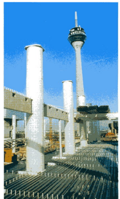
Deckenebene mit Verbundblechen
