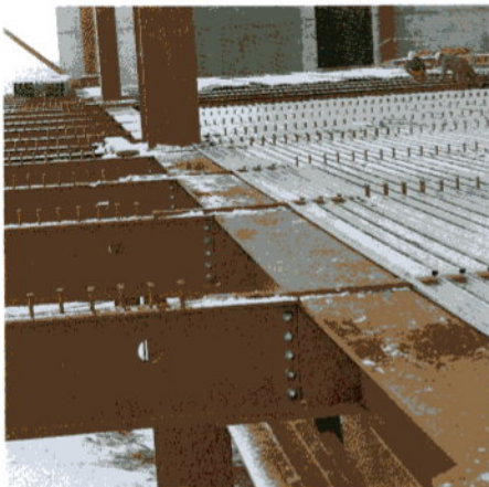
Anschluß eines Durchlauf-Verbundträgers
