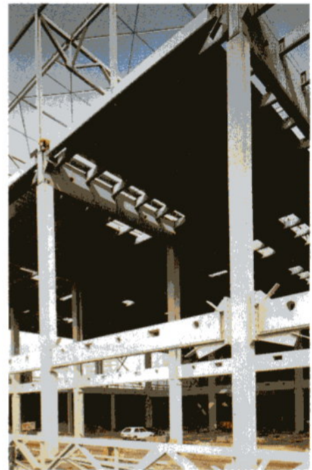
Kammerbetonierte Verbundstützen für einen Industriebau
