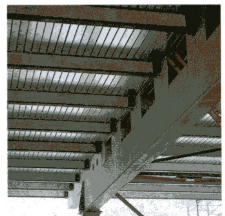
Hoher Verbundunterzug mit Regeldurchbrüchen und Verbunddecke
