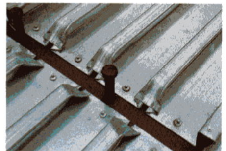
Trapezbleche mit Blechverformungsankern
