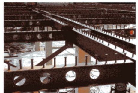
Verbundträger mit Stegaussparungen
