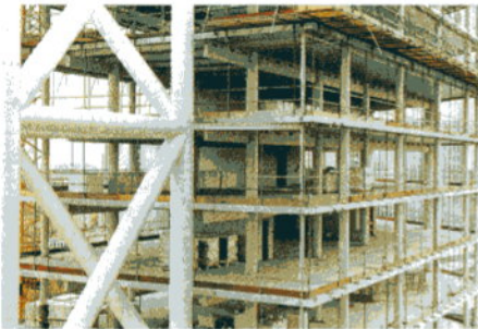
Blick in ein Regelgeschöß (links ein Fachwerktrum)
