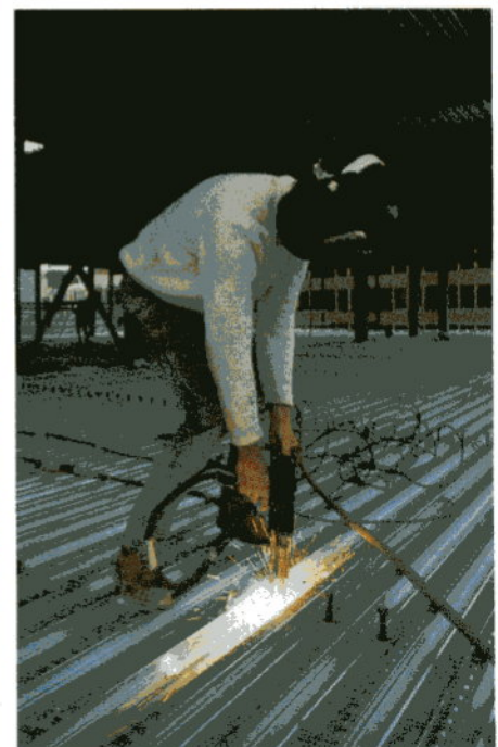
Aufschweißen von Kopfbolzendübeln auf der Baustelle mit dem Durchschweißverfahren
