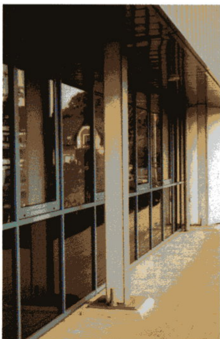
Kammerbetonierte Verbundstütze als sichtbare Außenstütze
