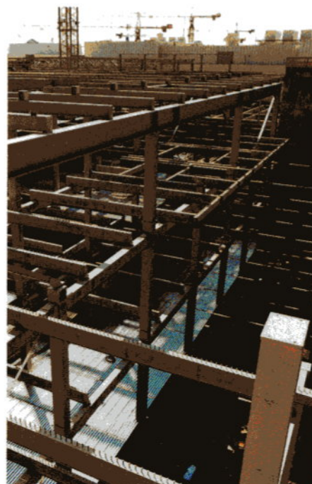
Mehrgeschossiger Industriebau mit Verbundstützen
