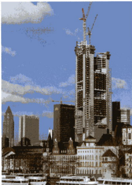
Rohbau ca. 200 m hoch
