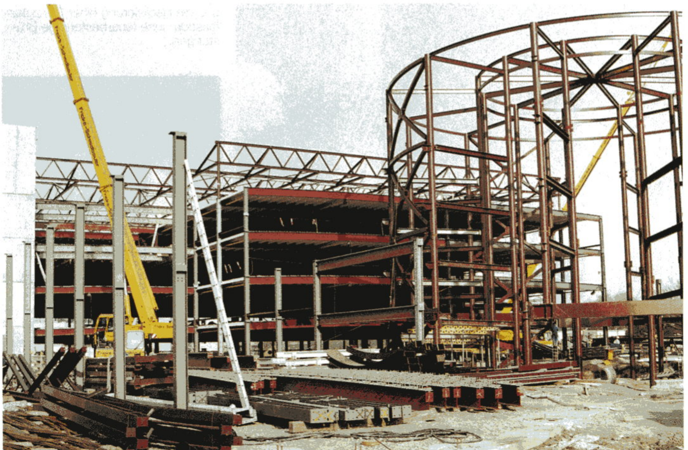
Rohbau Parkhaus 3 Flughafen Hannover
