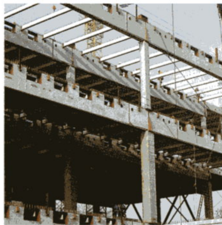
Zweigeschossige Industriebauten mit feuerbeständiger Verbundkonstruktion im Erdgeschoß
