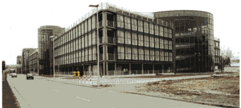
Neubau Parkhaus 3 Flughafen Hannover
