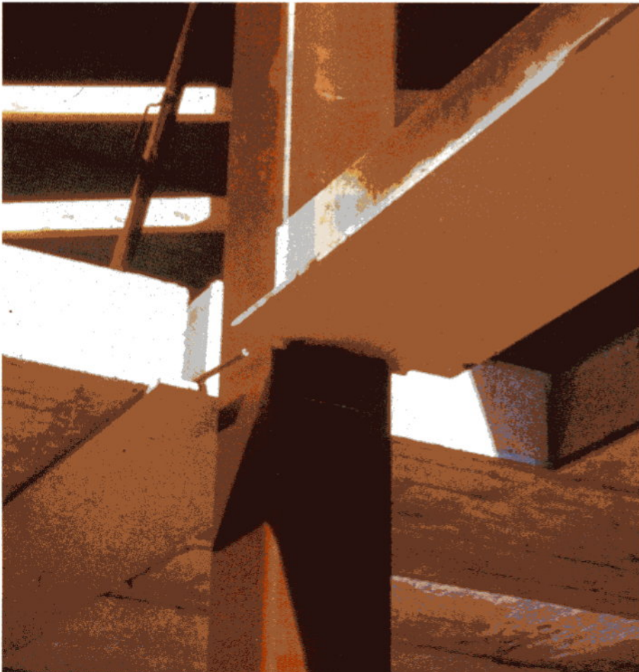
Montierter Flachdeckenträger (Hutprofil) mit verbreiterterem Untergurt
