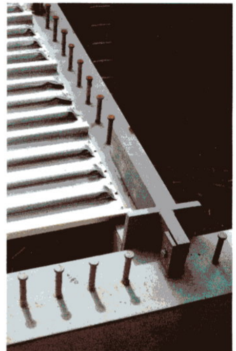
Schnabelanschluß eines kammerbetonierten Verbundträgers
