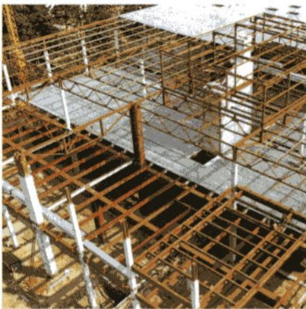
Zweigeschossige Industriebauten mit feuerbeständiger Verbundkonstruktion im Erdgeschoß
