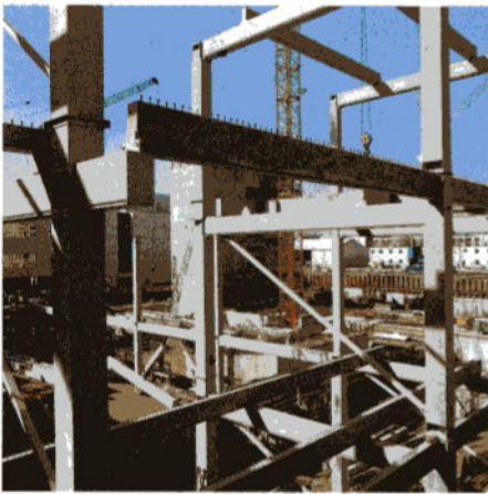
Montierter Verbundbau mit kammerbetonierten Profilen
