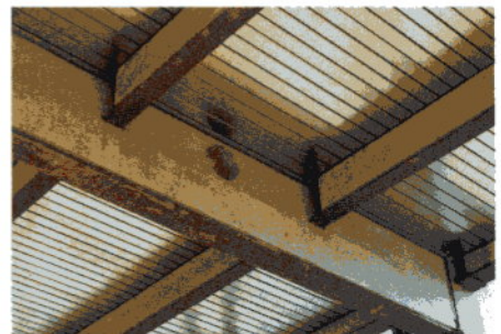
Feuerbeständige Verbundträger mit Kammerbeton
