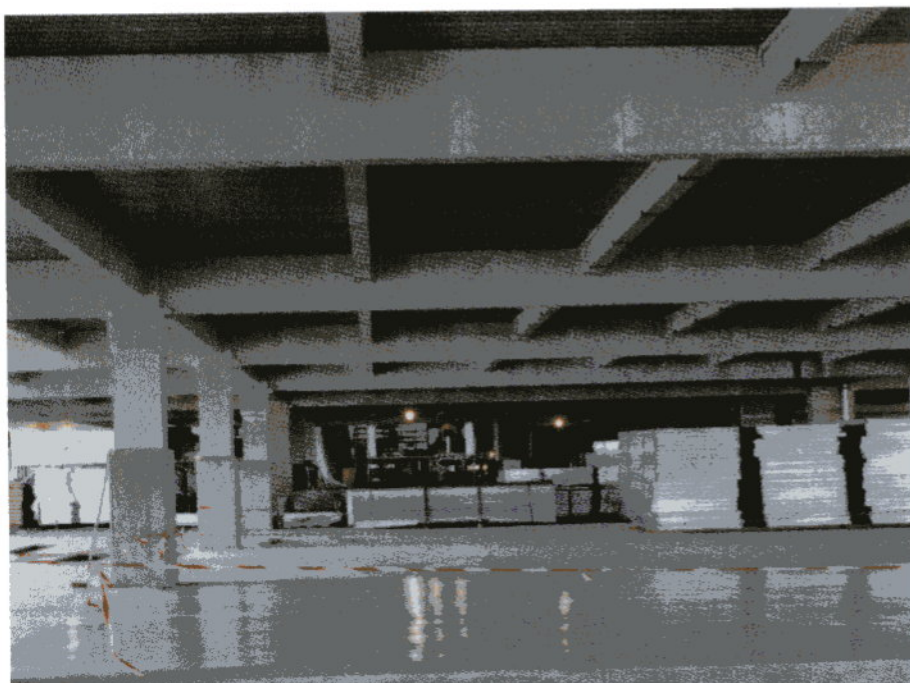
Mit Brandschutzplatten bekleidete Stahlkonstruktion
