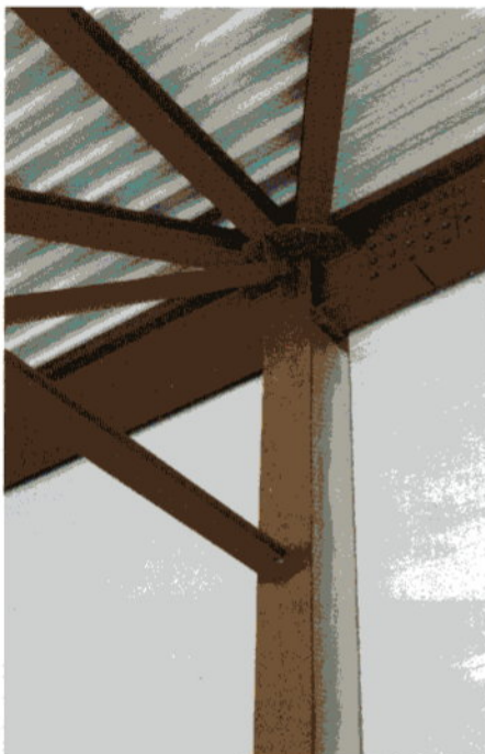
Stahlbaumäßige Anschlüsse an eine kammerbetonierte Verbundstütze
