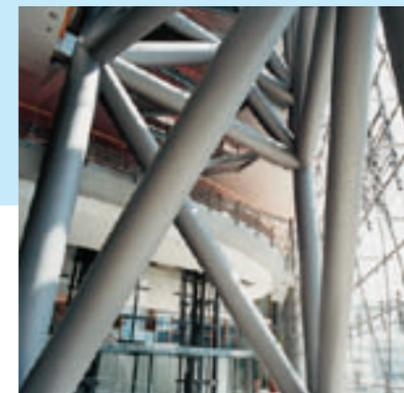
Das Bürogebäude steht auf der südlichen Einfahrt des Rheinufertunnels, der die Bundesstraße unter die Rheinuferpromenade führt. Zwei jeweils 19-geschossige Türme gründen auf den äußeren beiden Tunnelröhren und werden mit einem 3-geschossigen Riegel verbunden, so dass der Eindruck eines Tores entsteht.
