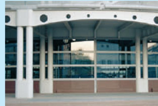
Am Fuße des ebenfalls von Helmut Jahn entworfenen Messturmes steht in Frankfurt das Eingangsbäude der Messe. Es ist ein dreigeschossiger Stahl-skelettbau, dessen Doppelstützen aus ausbetonierten Stahlrohren bestehen.
