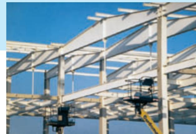
Das dreigeschossige Impfstoffwerk Dessau ist 74 Meter lang und 38 Meter breit mit einer Höhe von 13 Metern. Bei dem Gebäude in Stahl-/Stahlverbundbauweise ist eine neuartige Brandschutzkonzeption realisiert worden.
