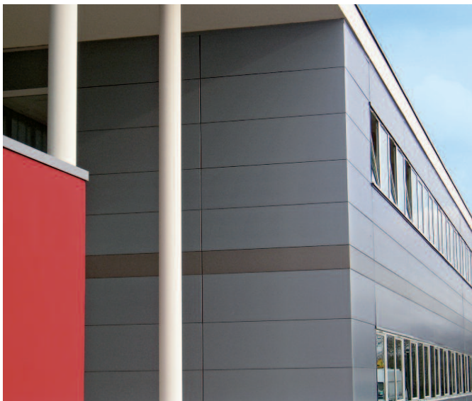
Bild 14a und b: Fassadenelemente mit ebener Deckschale
