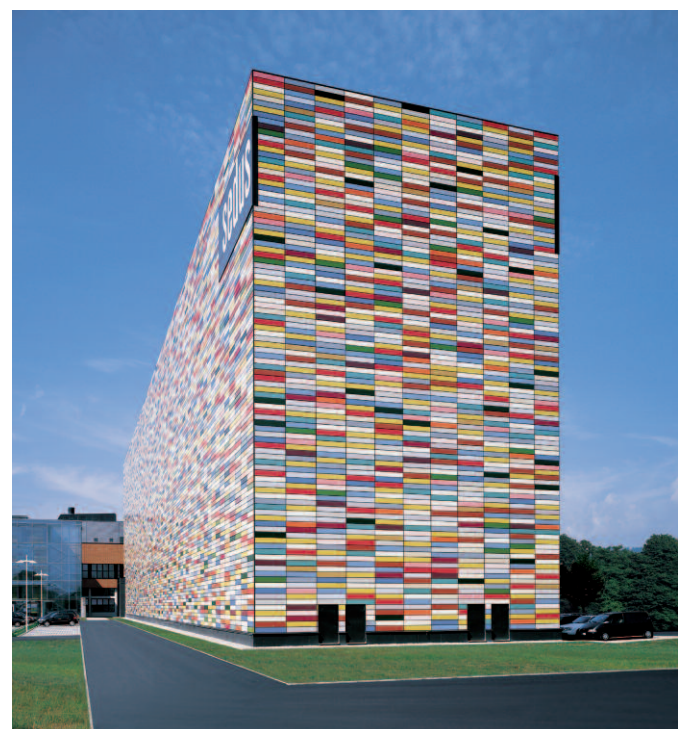
Bild 22: Möglichkeiten der Farbgestaltung von beschichtetem Feinblech
