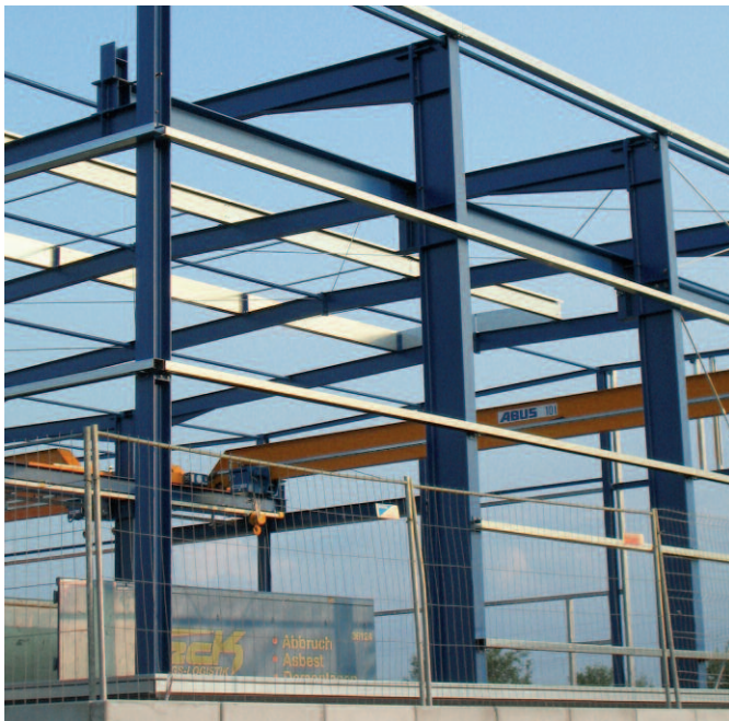
Bild 28: Unterkonstruktion für eine Sandwichelement-Fassade
