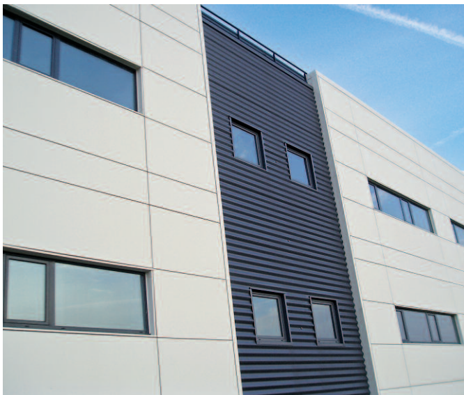
Bild 12: Beispiel einer Sandwichelement-Fassade
