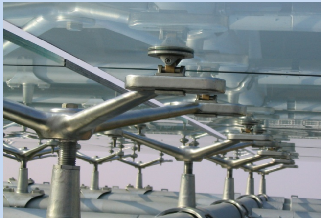
Montage- und Demontagegerechte Verbindungstechnik: Stahlträger einer Flachdecke mit Einhakmontageanschluss Punktförmige, verschiebliche Lagerung von Verbundsicherheitsglas
