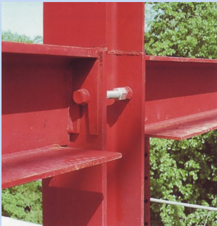
Montage- und Demontagegerechte Verbindungstechnik: Stahlträger einer Flachdecke mit Einhakmontageanschluss Punktförmige, verschiebliche Lagerung von Verbundsicherheitsglas
