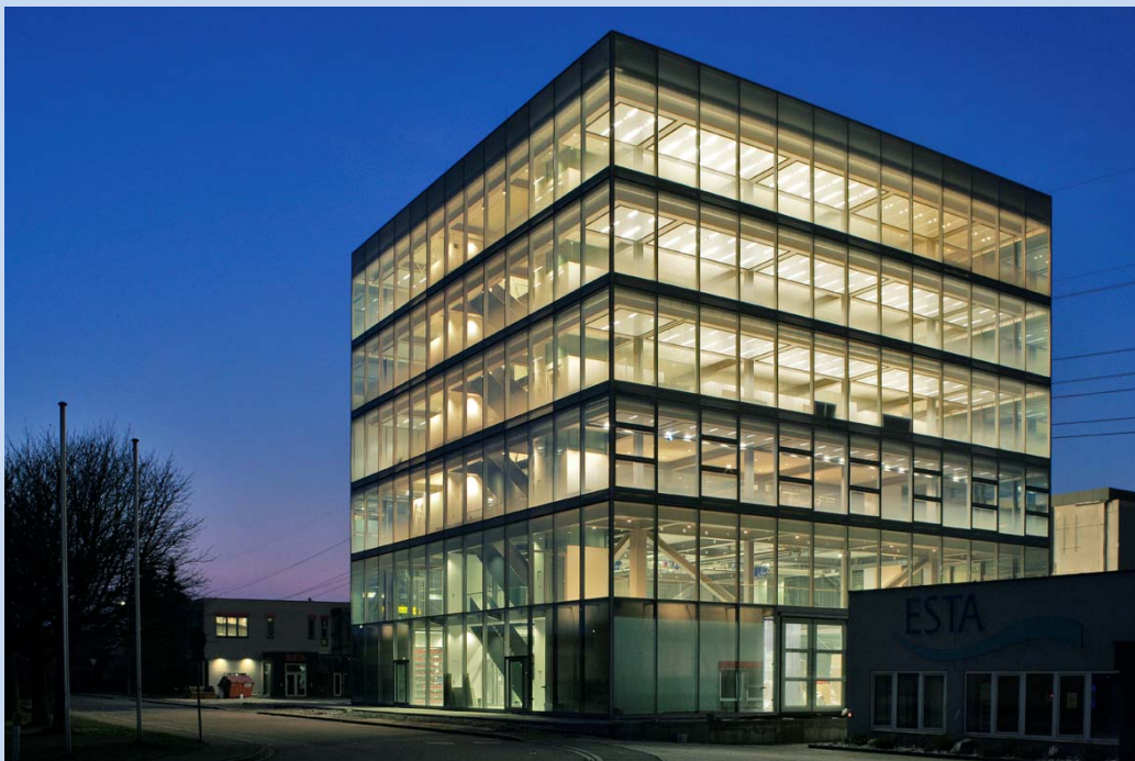
Montage- und Verwaltungszentrum ESTA, Senden (Gerken Architekten+Ingenieure © Martin Duckek)
