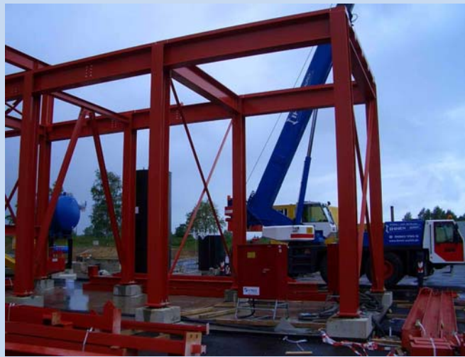
Stahlbaumontage at it's best: leichte, passgenaue, fertig beschichtete, just-in-time angelieferte Bauteile werden montiert.
