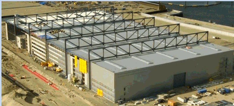
Airbus A380 Sektionsbauhalle, Hamburg-Finkenwerder: Volumeneffizienz durch außenliegendes Tragwerk
