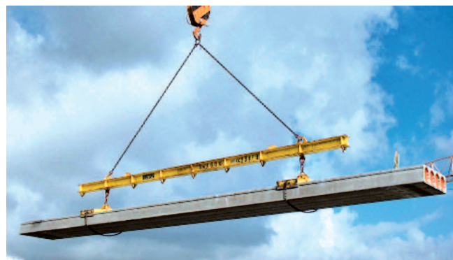
Bild 1: Montage von Spannbeton-Fertigdecken
