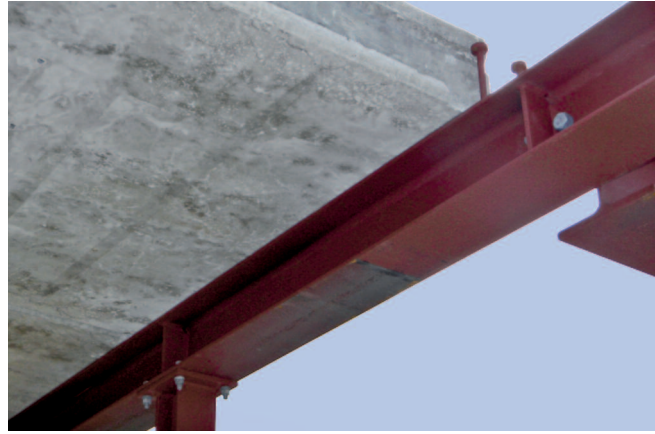
Bild 18: Träger mit Kopfbolzen zur Ringankerwirkung
