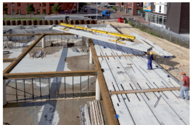
Bild 15: Deckenmontage in deckengleichen Stahlträgern
