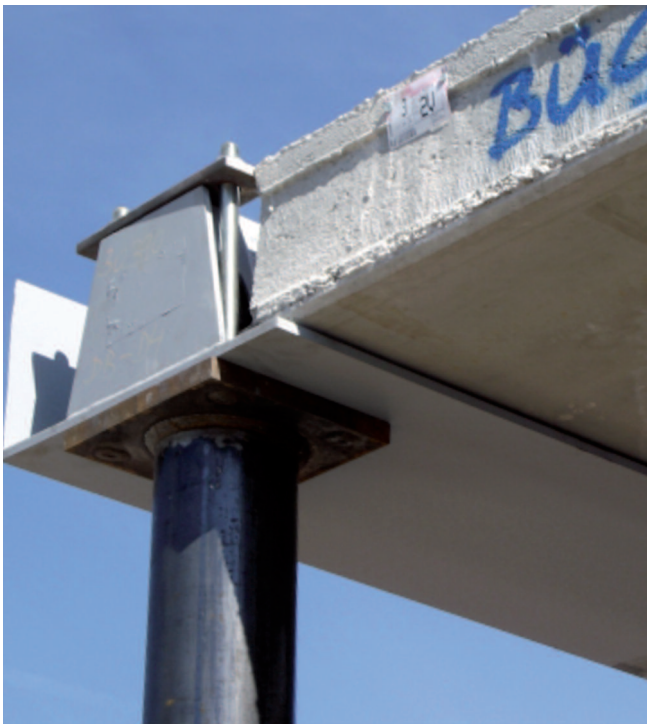
Bild 17: Randträger als Slim Floor – Auflager
