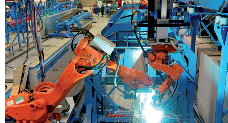
Industrie 4.0: vollautomatische Stahlbaufertigung bei RSB (Quelle Foto: RSB)
