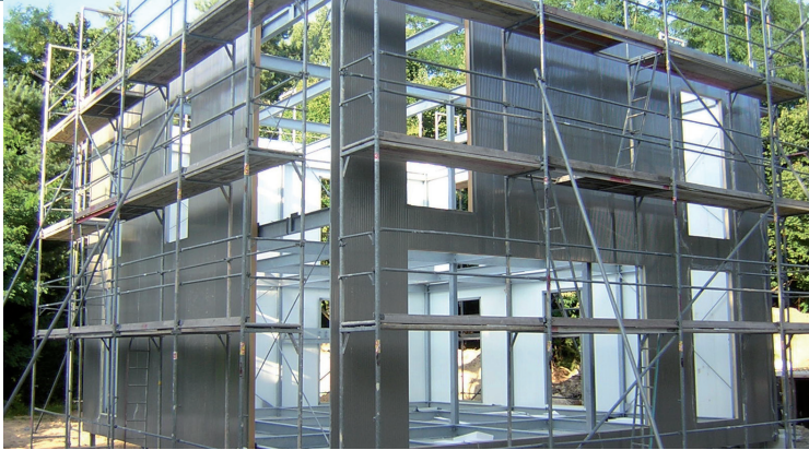
Separate, nicht tragende Fassade, die jederzeit ausgetauscht werden kann (Quelle Foto: RSB)
