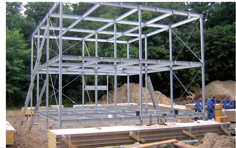
Tragendes Stahlskelett für maximale Flexibilität (Quelle Foto: RSB)
