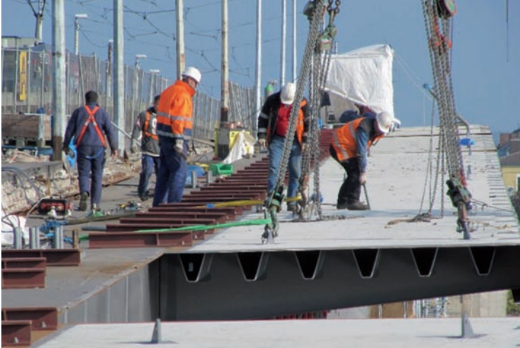
Verbreiterung der Kennedybrücke in Bonn © Eiffel Deutschland Stahltechnologie
