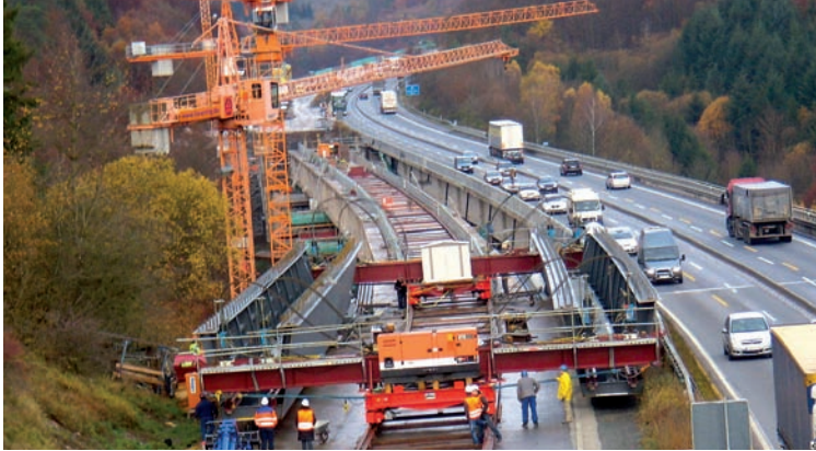
Einfahren der neuen Stahlträger mittels Schwerlastgleiswagen © Donges SteelTec
