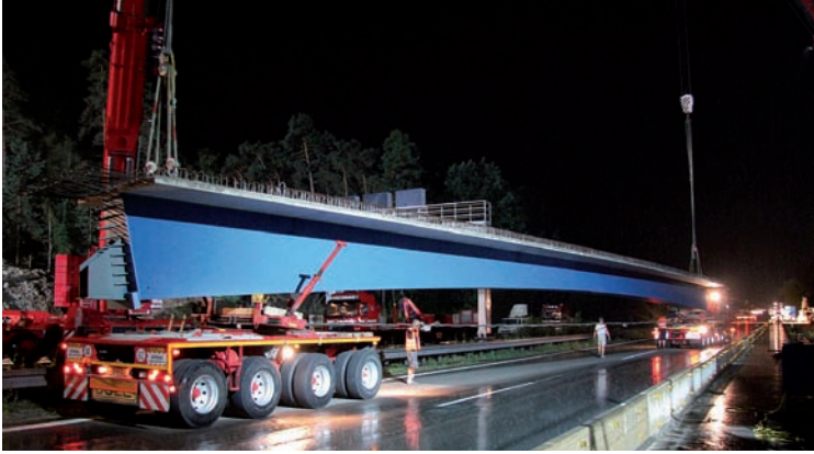
Anlieferung der Stahlverbundträger© Donges SteelTec
