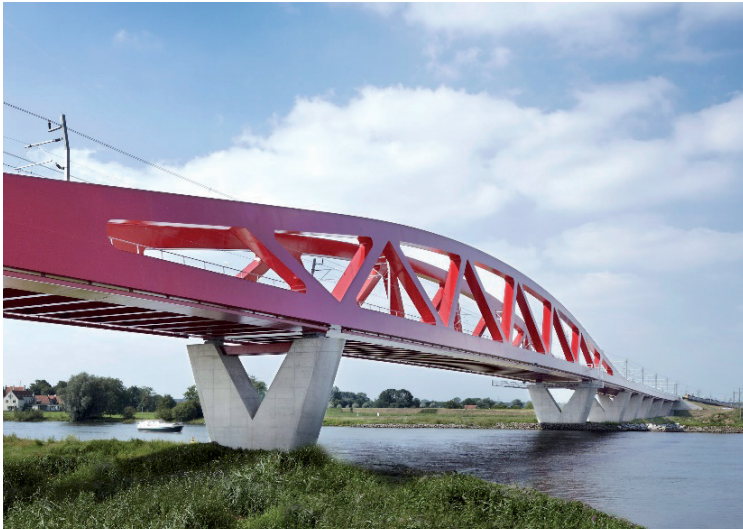
»Design and Build« Eisenbahnbrücke über die IJssel © Florian Schreiber
