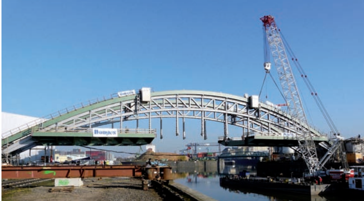
Montage der neuen Brückenkonstruktion © Donges SteelTec
