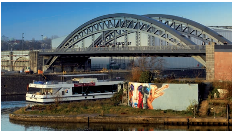
Die neue alte Honsellbrücke © Donges SteelTec
