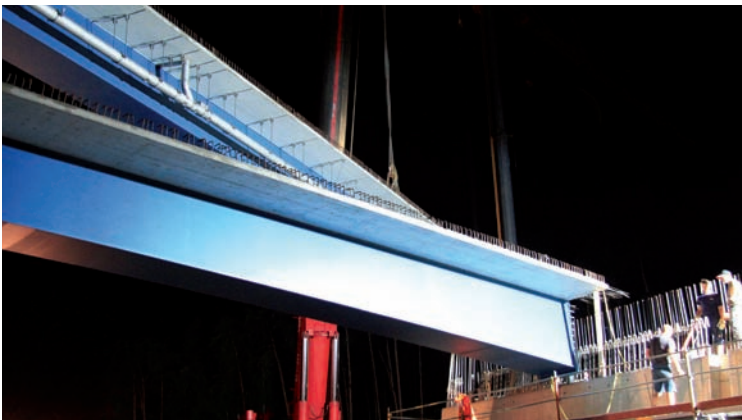
Einhub der Stahlverbundträger in Sperrpause © Donges SteelTec
